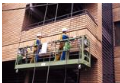
写真3. ゴンドラ足場/ビソーwebより
