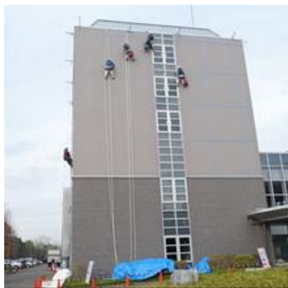
写真4. ブランコ足場/外装専科 webより
